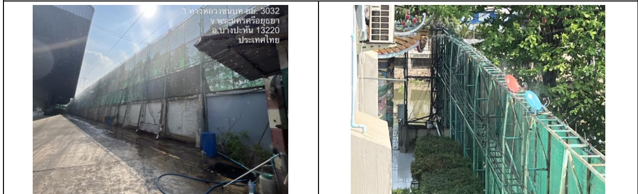
สแลนป้องกันฝุ่นและระบบสปริงน้ำบริเวณด้านหน้าของโครงการ
